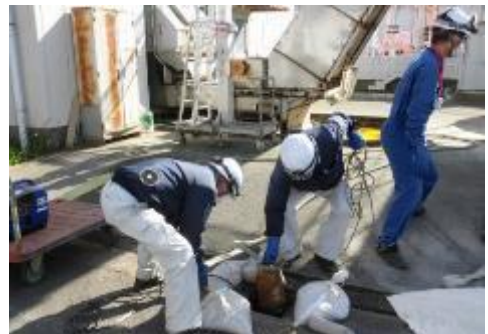
常駐会社も参加し、対応手順を確認
